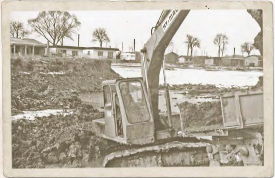
Erdbewegungen bei der Sanierung 1970. / Foto aus Bestand Gerhard Zodl.
